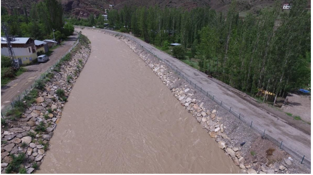
Şekil 1.7. Taş Tahkimat Taşkın Koruma Yapısı (Anonim 2021f)
