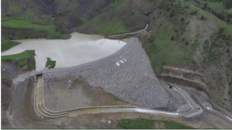
Şekil 1.10. Geçirimsiz Malzeme(Kil) + Kaya Dolgu Baraj Erzurum Tortum Pehlivanlı Barajı (Anonim 2021i).
