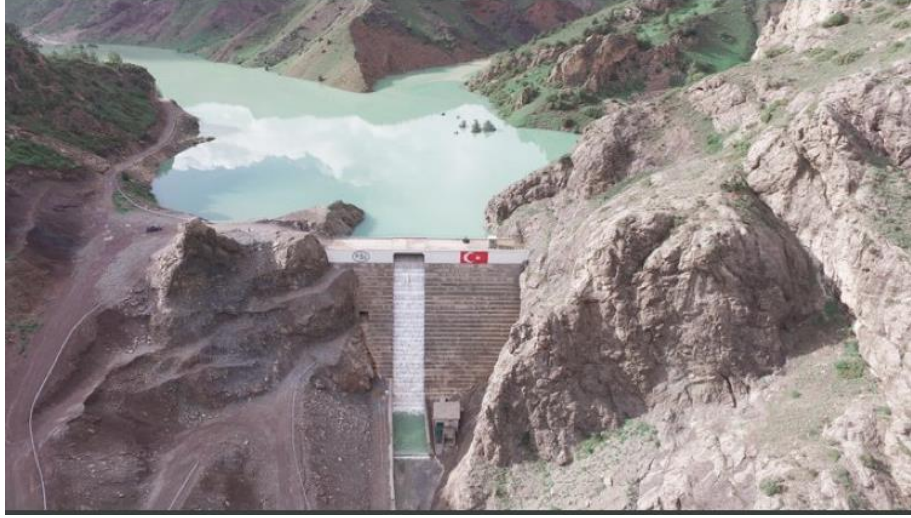
Şekil 1.9. Silindirle Sıkıştırılmış Beton Baraj Erzurum Oltu Sivridere Barajı (Anonim 2021h).
