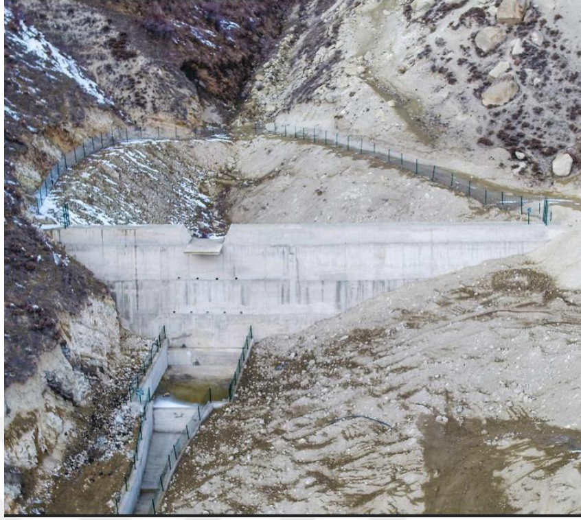
Şekil 1.5. Beton Tersip Bendi (Anonim 2021d)
