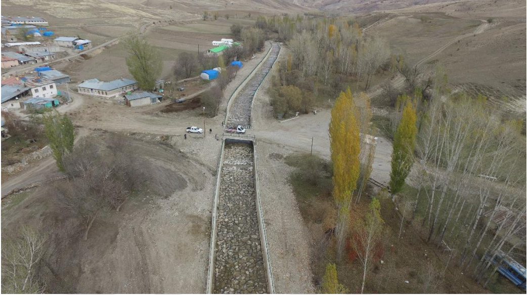
Şekil 1.8. Beton Kanal Taşkın Koruma Yapısı (Anonim 2021g)
