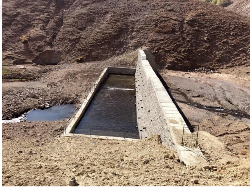
Şekil 1.6. Kargir Tersip Bendi (Anonim 2021e)
