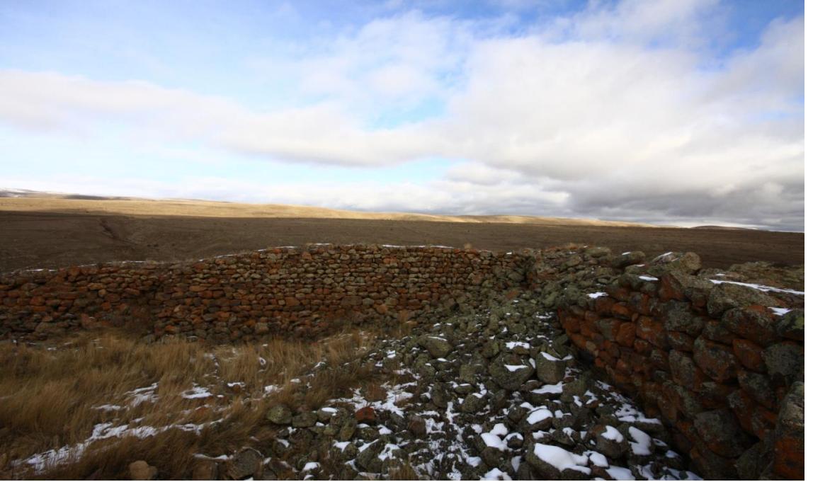
Fotoğraf 14. Kapıkaya Kalesi, Kiklopik Teknikte Yapılmış Sur Duvarları
