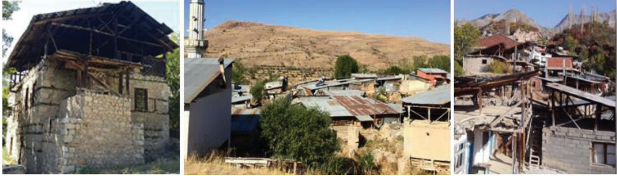
Görsel 31-32-33. İspir/Sırakonaklar Köyü, Pazaryolu Gölyanı Köyü ve Uzundere Kirazlı Köyü’nde çatı yükselteleri
