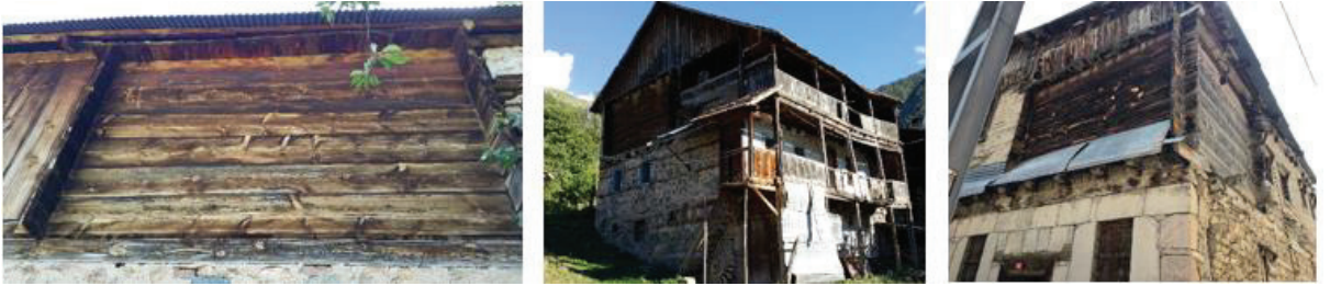
Görsel 40-41-42. İspir/Devedağı Arif Küçük ve Şamil Polat Evi ile Uzundere/Dikyar Köyü Mehmet Arslan Evi'nde dış cepheye yansıyan ambarlar
