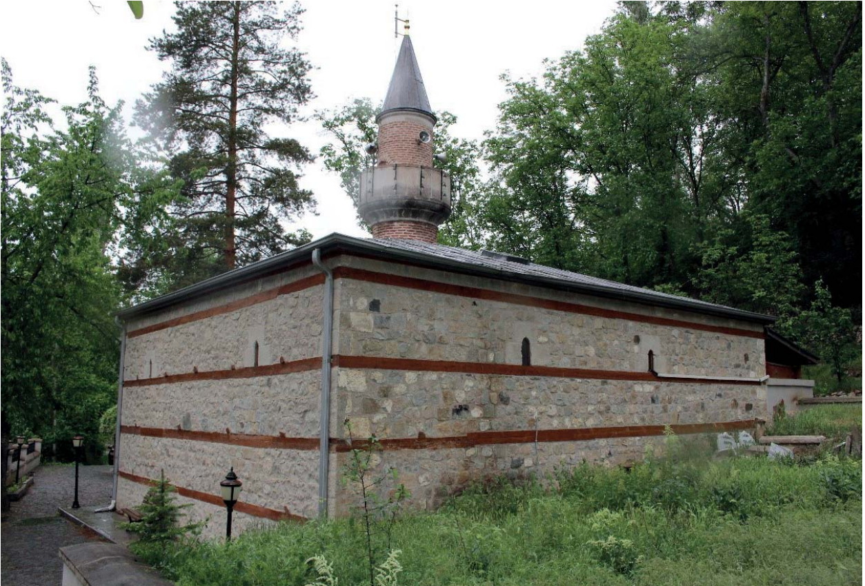
Foto. 44. İnce Camii Genel Görünüm
