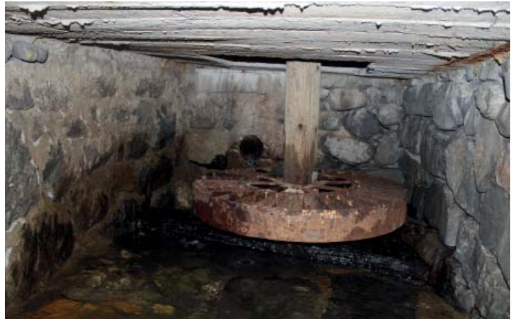
Foto. 22. Aşağı Ulubağ Mahallesi Dink (Bulgur Değirmeni) Domuzluk Görüntüsü
