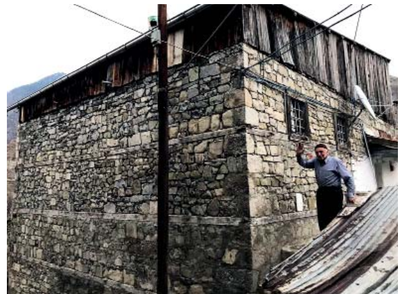
Foto. 12. Enver Arslan Evi Batı Cephe
