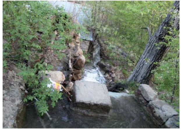
Foto. 9. Gölbaşı Mahallesi Değirmen-II Su Kanalı
