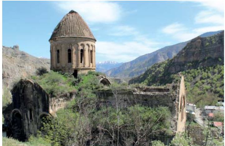
Foto. 4. Öşvank Kilisesi Kuzey Cephe
