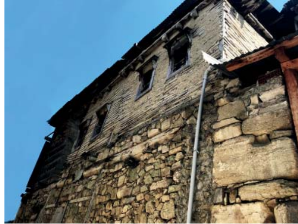
Foto. 1. Mehmet Arslan Evi Güney Cephe
