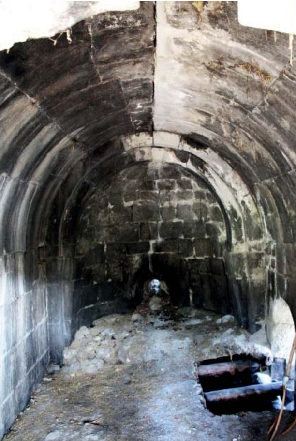
Foto. 14. Şapelin İç Kısmından Görünüm
