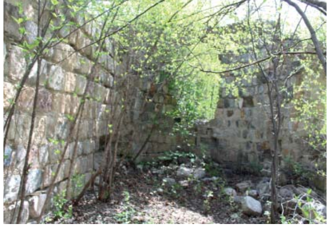
Foto. 16. Şapelin İç Kısmından Görünüm
