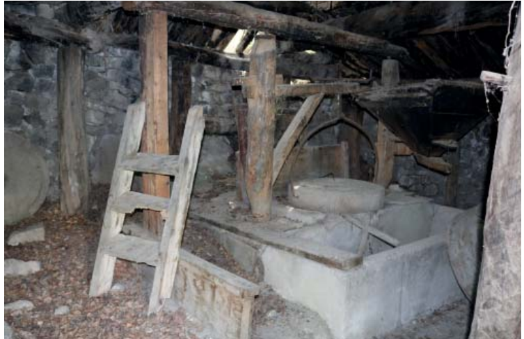
Foto. 18. Çağlayan Mahallesi Değirmeni İç Görüntüsü
