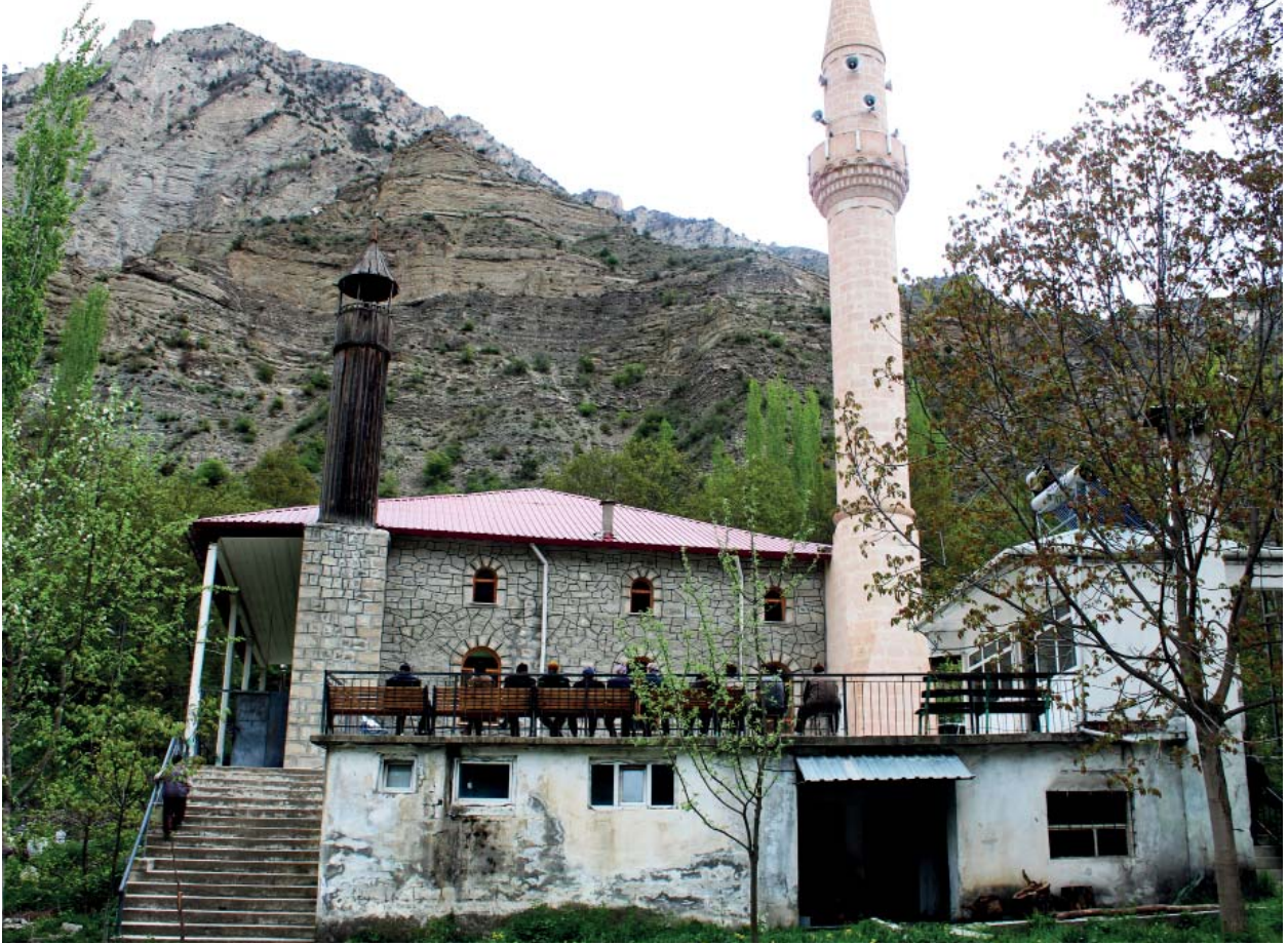
Foto. 8. Cevizli Camii Batı Cephesi
