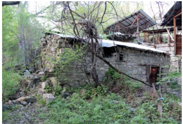
Foto. 6. Gölbaşı Mahallesi Değirmen-II Genel Görüntüsü
