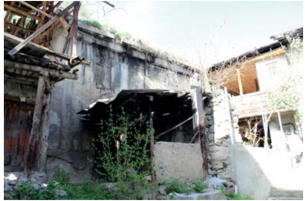
Foto. 13. Şapelin Güney Cephesi
