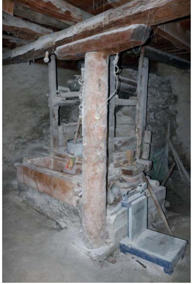
Foto. 5. Gölbaşı Mahallesi Değirmen-I İç Görüntüsü
