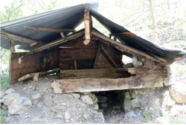
Foto. 11. Ulubağ Mahallesi Değirmeni Yakın Görüntüsü
