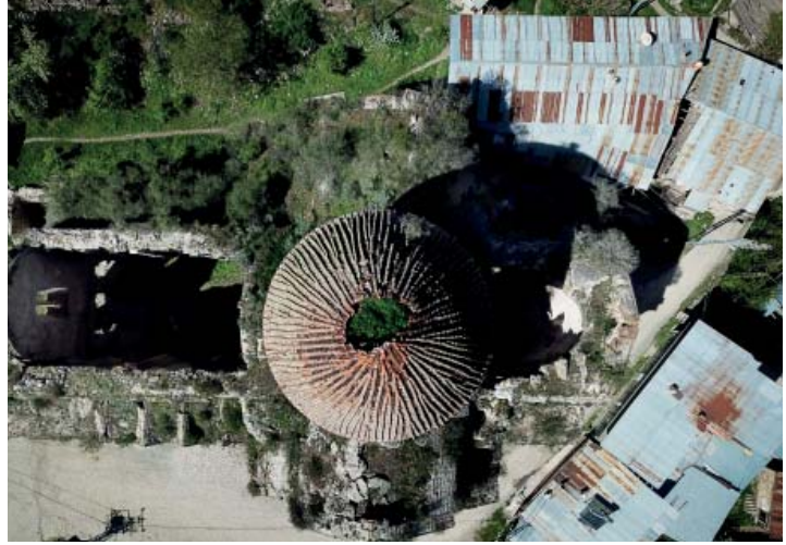
Foto. 3. Öşvank Kilisesi Havadan Görünüm
