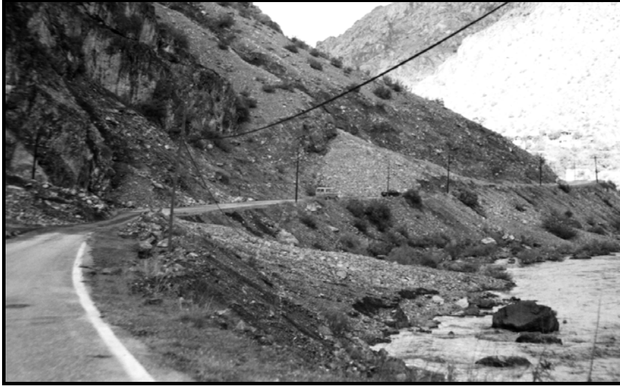
Fotoğraf 9. Su Kavuşu'mu Yusufeli arasındaki yaklaşık 8 km'lik yol boyunca yüzlerce konumda kısa aralıklarla küçük dere yataklarından taşınan malzeme ulaşımı engelleyecek binlerce ton malzemeyi karayoluna ve Çoruh Vadisi'ne indirmektedir.
