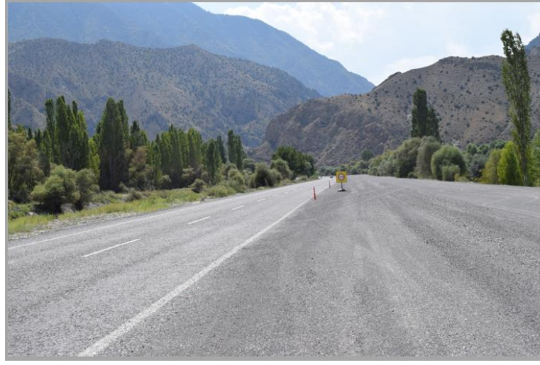
Şekil 22. Uzundere bölünmüş yol çalışması
